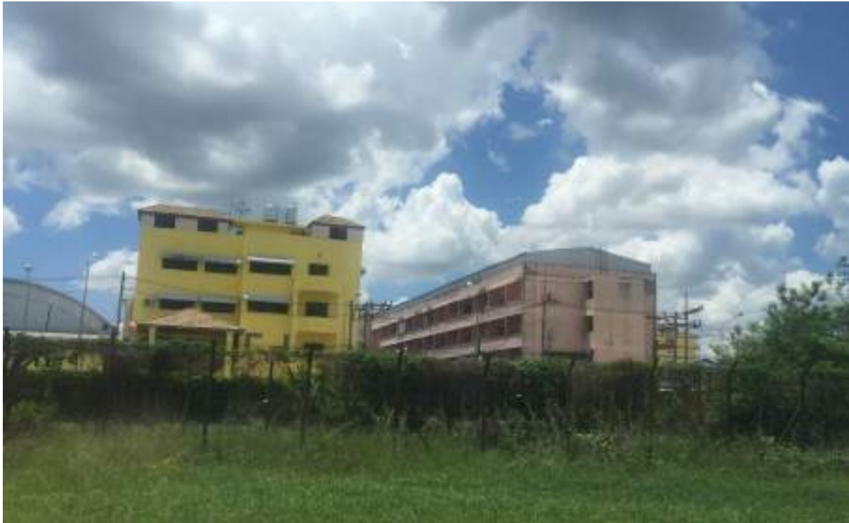
Gambar 59 : Bangunan komersil juga dibina hampir dengan pagar keselamatan sempadan Malaysia – Thailand berhampiran Pos BKC 7.
