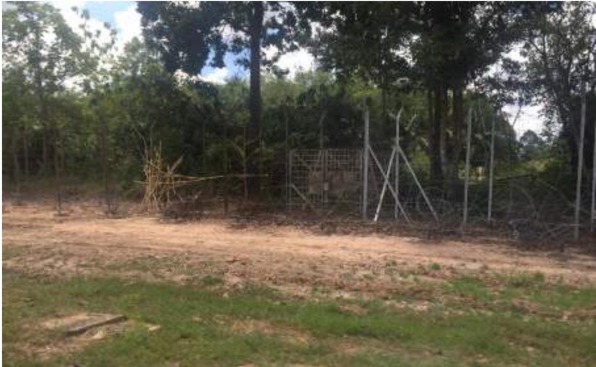
Gambar 55 : Pagar keselamatan dua lapisan yang telah rosak di sepanjang sempadan Malaysia – Thailand menuju ke Bukit Kayu Hitam.
