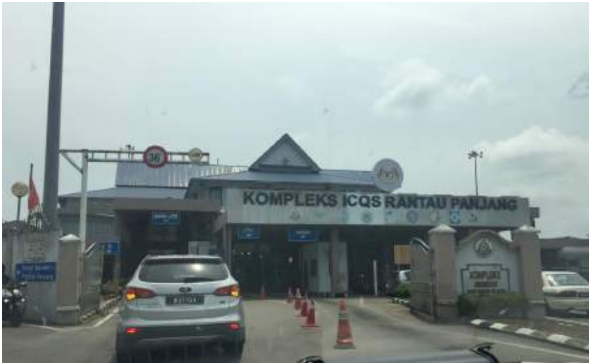
Gambar 72 : Kompleks ICQS Rantau Panjang.
