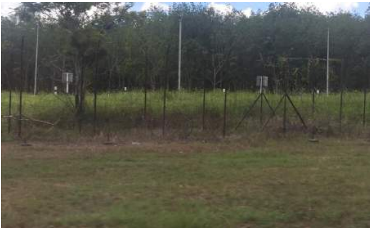
Gambar 56 : Di sepanjang bahagian Thailand terdapat jalan raya dua hala bersebelahan dengan pagar keselamatan Malaysia-Thailand.
